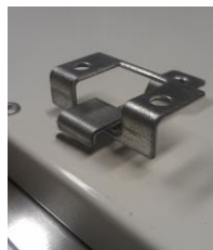
Detail eingehängte Deckenhalter
